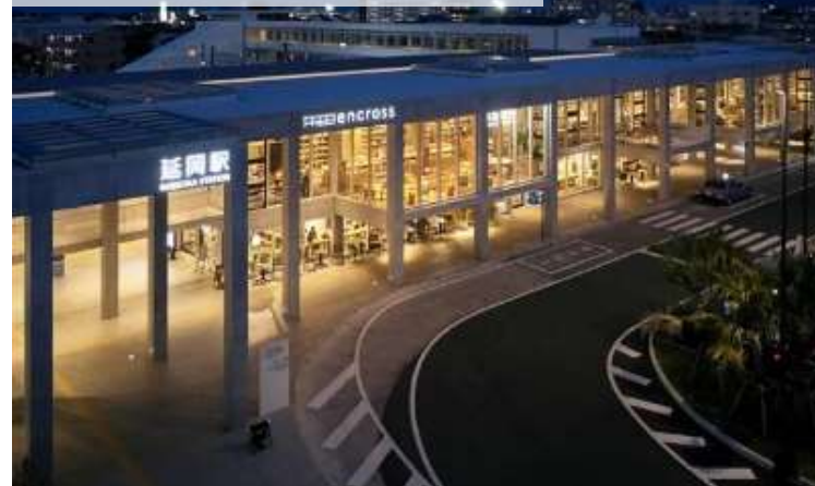
みなとと接続した駅前空間（延岡）
