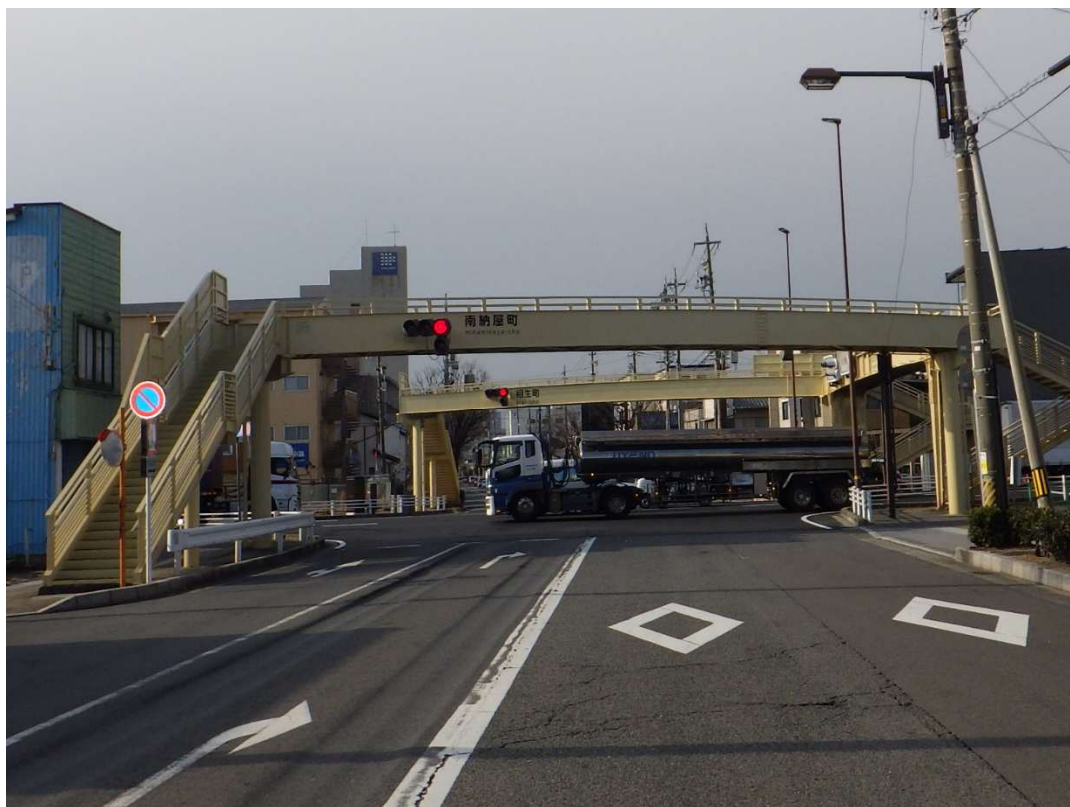
くらまち 蔵町歩道橋 すわしんどう 諏訪新道線
