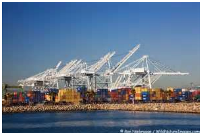
ガントリークレーンが並ぶロングビーチ港
