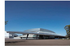
四日市市総合体育館
