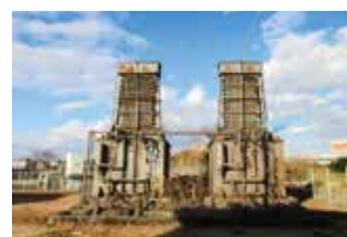
現存する2基の濾過機器
