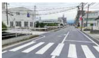
◀霞ヶ浦垂坂線 再舗装
