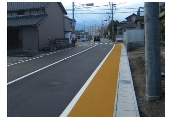
図：カラー舗装(日永東日野線)
