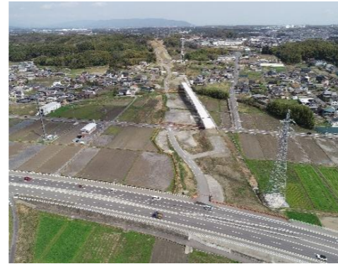
図：整備が進む北勢バイパス
