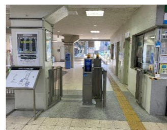
図：四日市あすなろう鉄道に導入した交通系ICカードシステム
