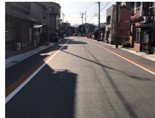
図：側溝整備(中浜田南浜田線)
