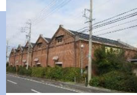
旧東洋紡績富田工場原綿倉庫
