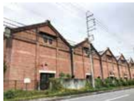
現在もモールの一角に残る原綿倉庫
