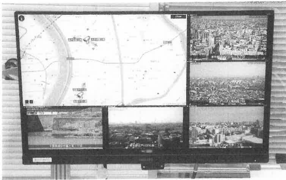
防災危機管理課に設置された、AI カメラによる画像を映すモニター
