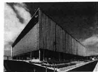
屋根付き多目的広場外観
