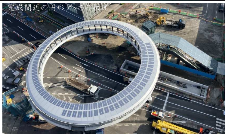
円形デッキの景観照明試験点灯の状況
