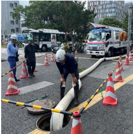
ポンプ車による排水状況
