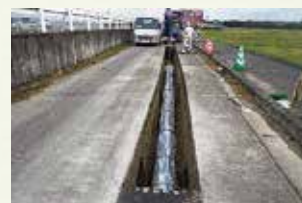
ダクタイル鋳鉄管の布設替え工事
