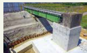
水道施設(水管橋)の耐震補強
