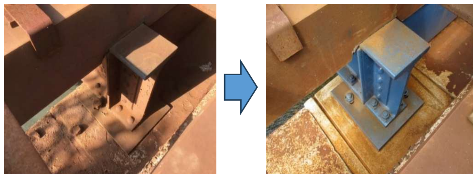
三岐鉄道三岐線 高見台開渠補修
