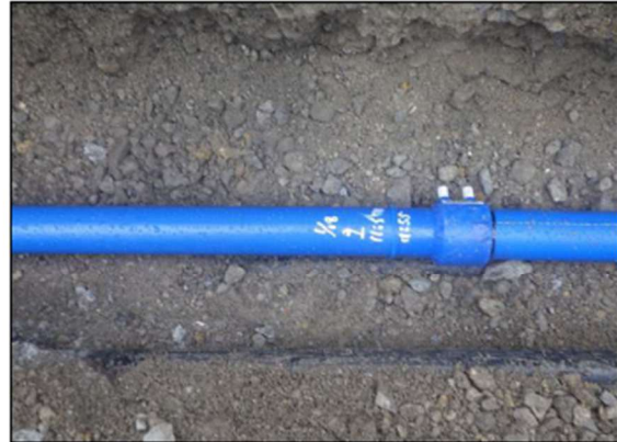
更新後 (配水用ポリエチレン管) ※耐震管
