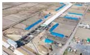
放水路の整備状況
