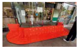
止水板の設置イメージ
