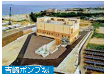
河川、下水道管、水路、ポンプ設備などの整備
