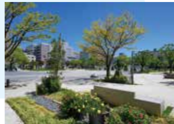
雨水を一時的に貯めて、浸透を促す雨庭
