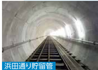
雨水流出抑制のための雨水貯留施設などの設置
