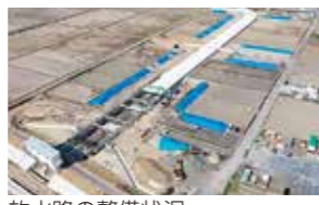
放水路の整備状況
