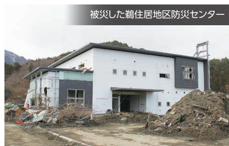
被災した鵜住居地区防災センター
