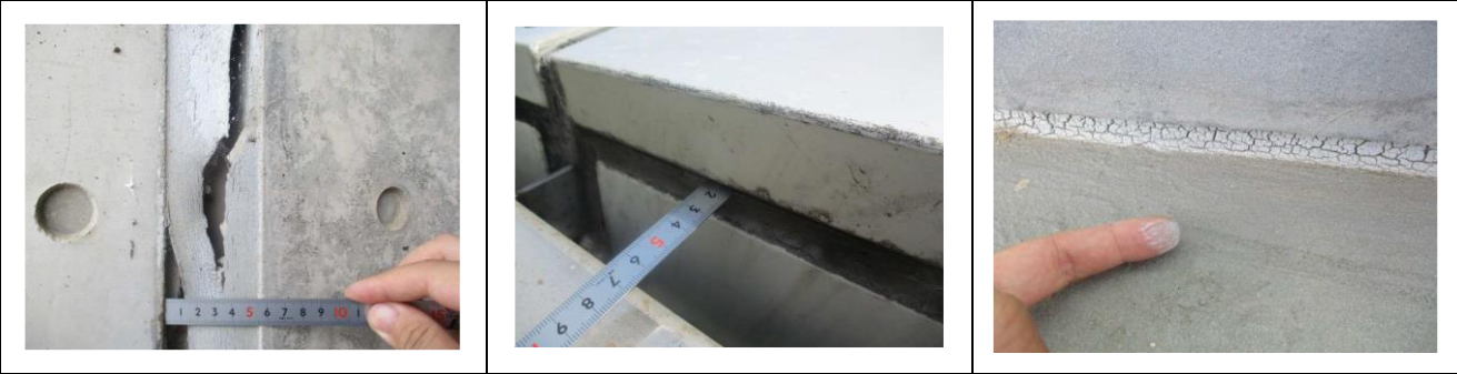
写真 シーリング材使用状況
