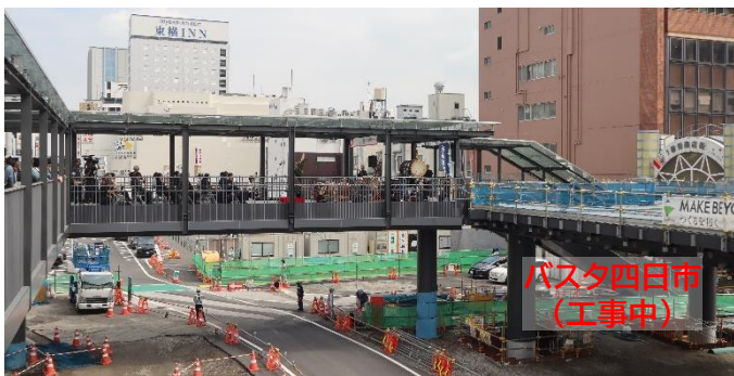
令和8年9月12日に供用開始した直線デッキの状況
