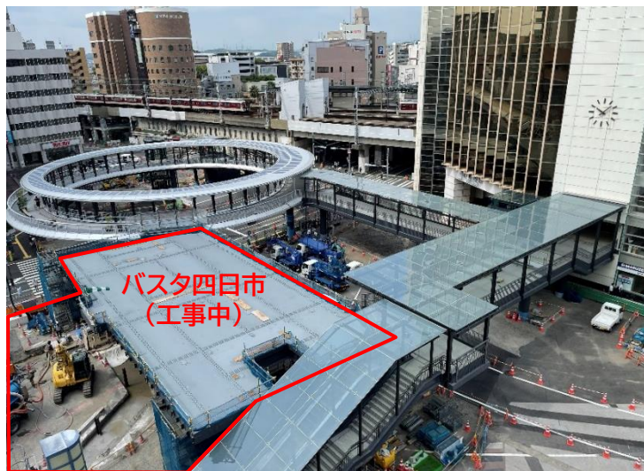
バスタ四日市施工状況(令和8年8月21日時点)
